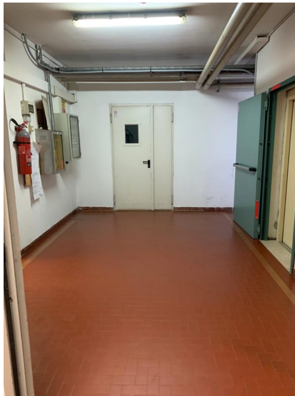
foto 08: corpo "A": locale filtro verso attuale cappella
