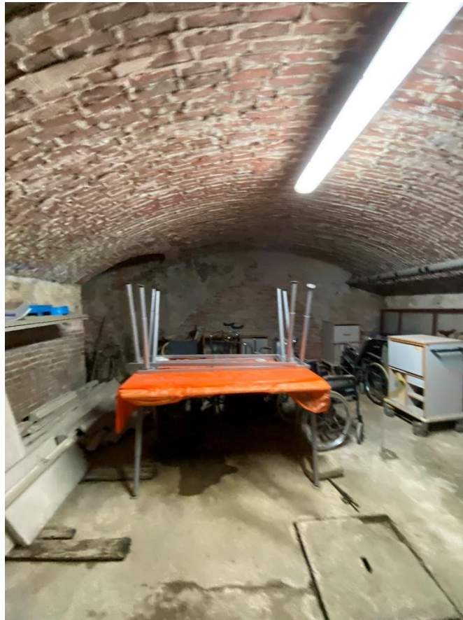
foto 01: corpo "B": locale deposito (particolare)
