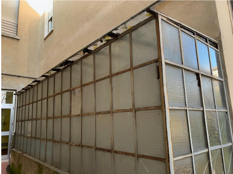
vista laterale - porzione vetrata
