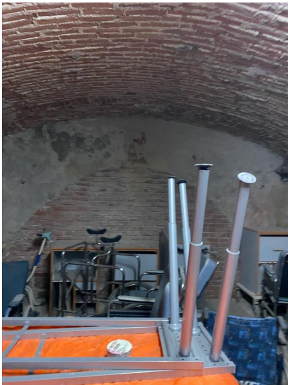
foto 01: corpo "B": locale deposito
