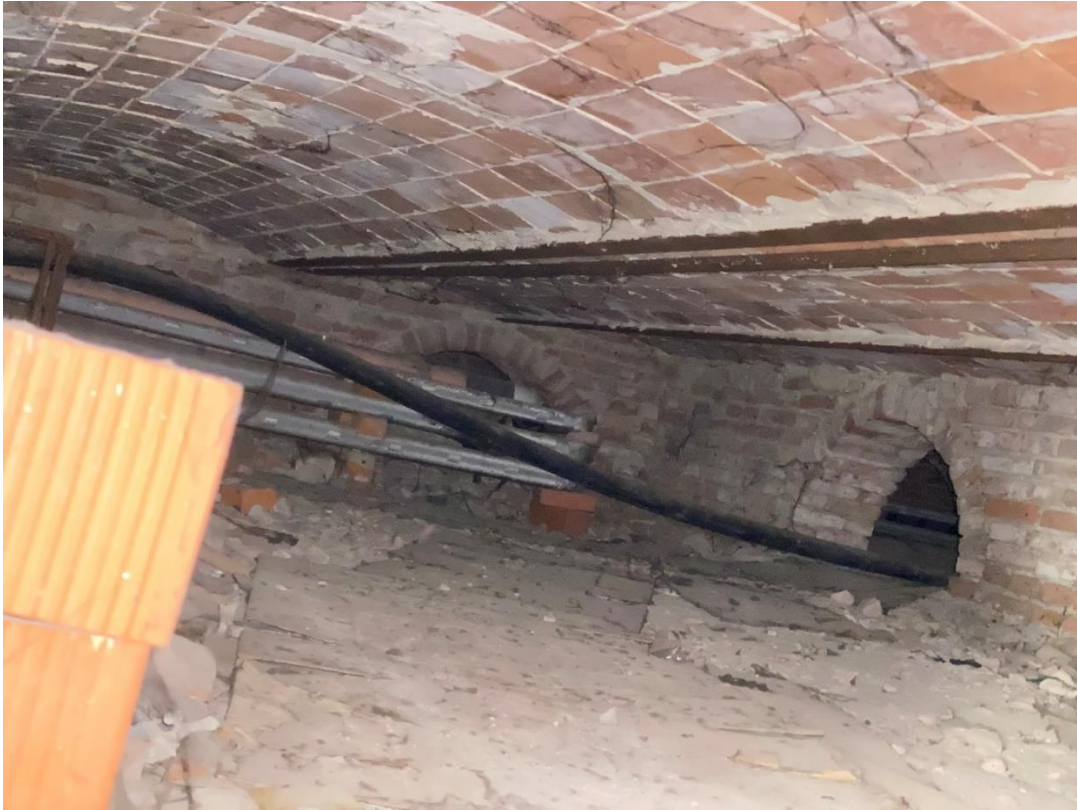
corpo "B" fabbricato originario : piano interrato - solaio a volterrane
