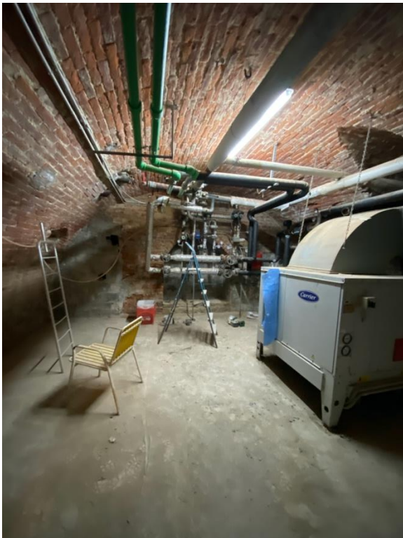
foto 03: corpo "B": locale tecnico
