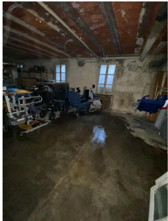
foto 02: corpo "B": locale deposito
