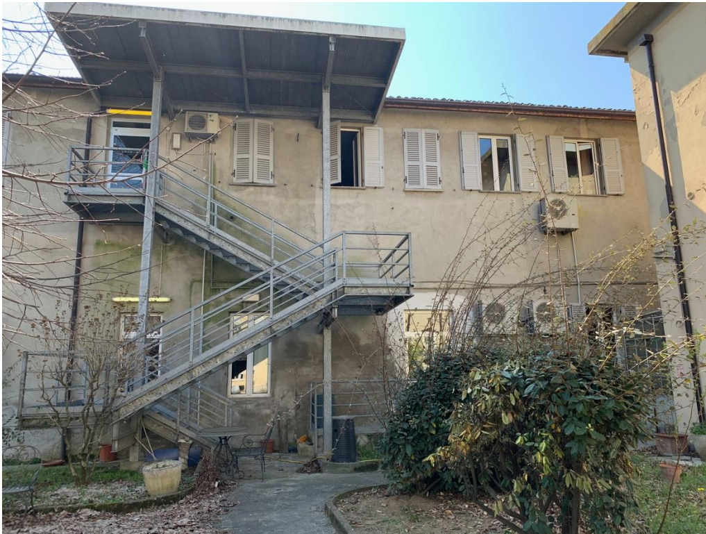
foto 06: vista corpo "C" da cortile interno lato Via Bottarone
