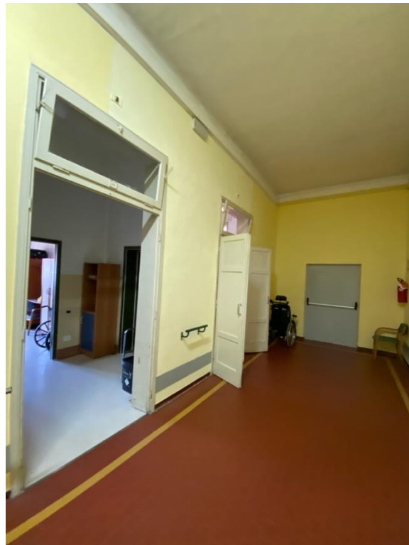
foto 04: corpo "B": corridoio interno di distribuzione
