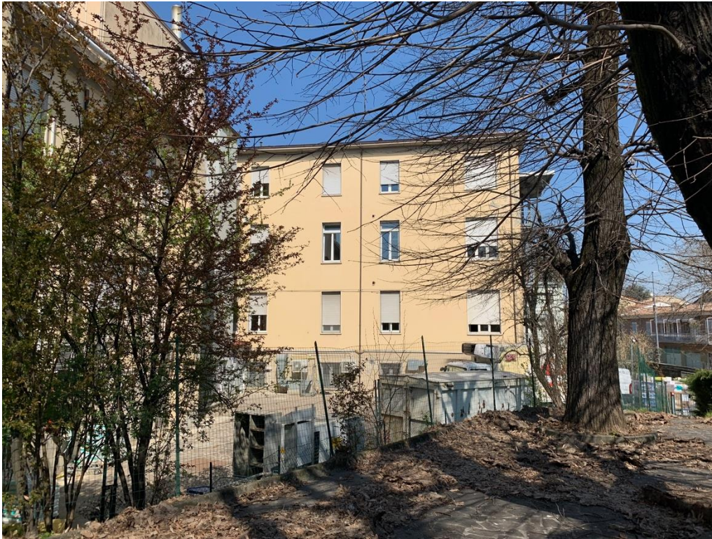
foto 02: vista corpo "A" da cortile interno – lato Via Bottarone
