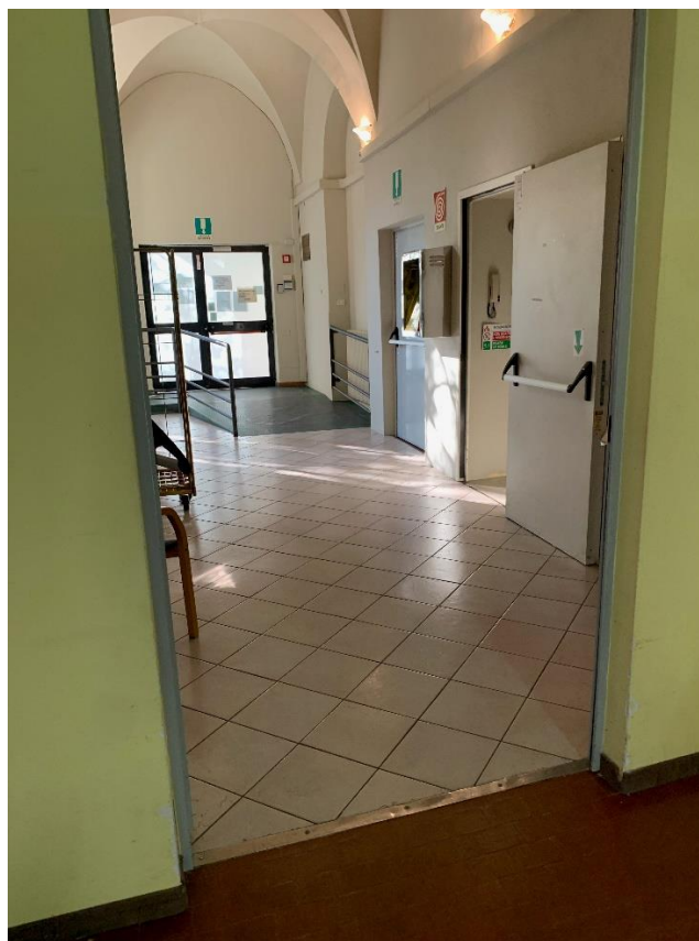
corpo "C": ingresso al reparto
