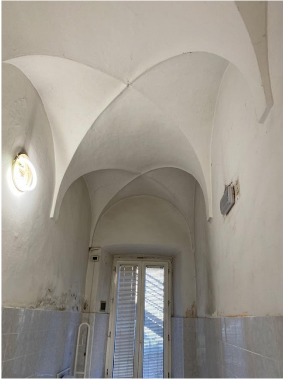
foto 03: corpo "C": servizio igienico
