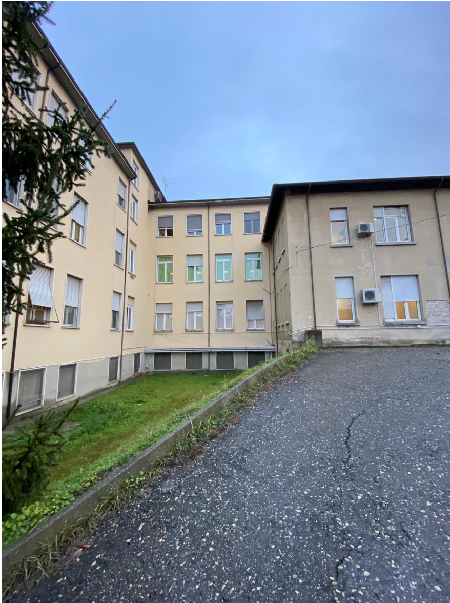
vista corpo di collegamento da rampa interna ( corpo "B" a destra ed "A" a sinistra)
