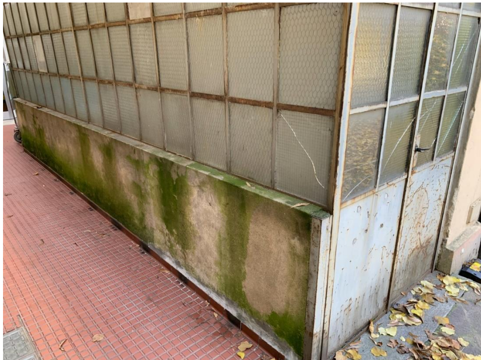
vista laterale – cordolo di base
